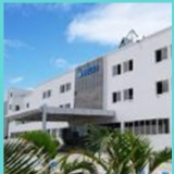
印度 Rudrapur LEED 黃金級
